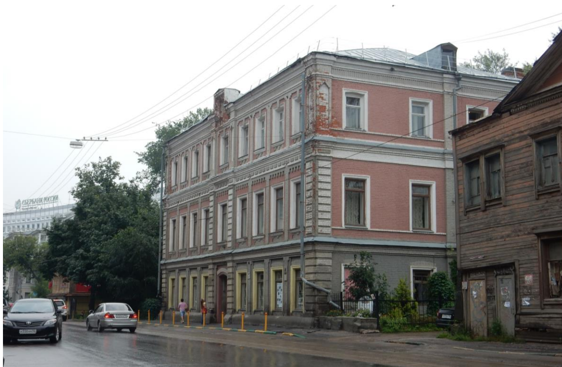
Рис. 2. Здание Ремесленной управы (ул. Октябрьская, 25) до реставрации. 2016 г.
