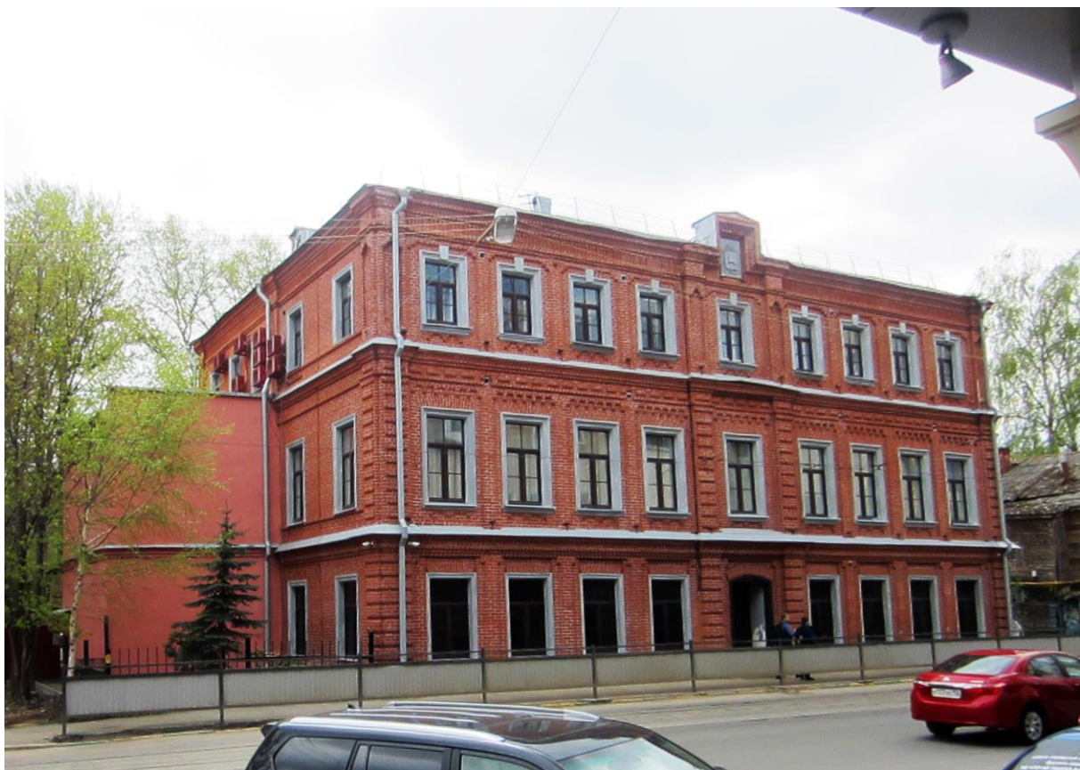
Рис. 4. Здание Ремесленной управы (ул. Октябрьская, 25) после реставрации. 2017 г.
