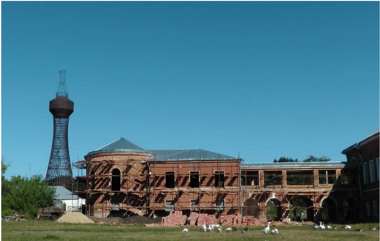
Водонапорная башня в с. Полибино Липецкой обл.
