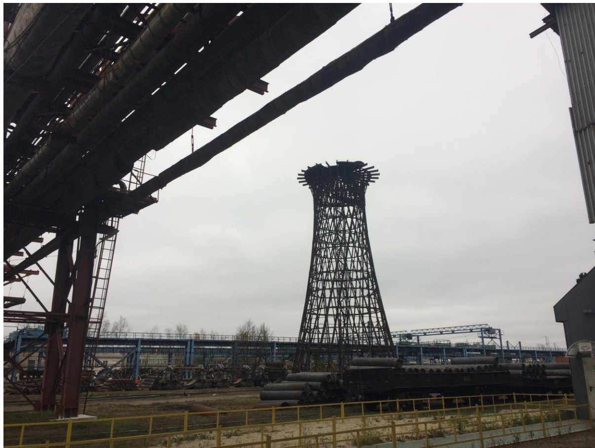
Общий вид башни. Фото 2016 г.
