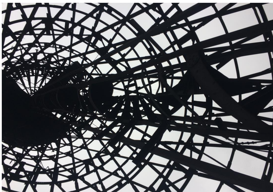
Рис.2. Шуховская башня. Вид на верхнюю площадку. Фото 2016 г.
