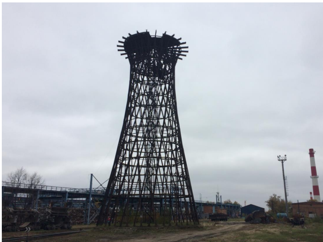
Рис.1. Шуховская башня. Общий вид. Фото 2016 г.
