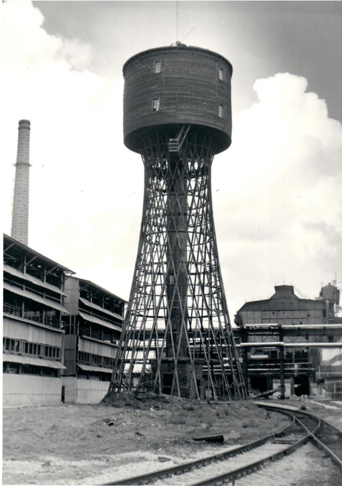
Рис.3. Общий вид башни до пожара
